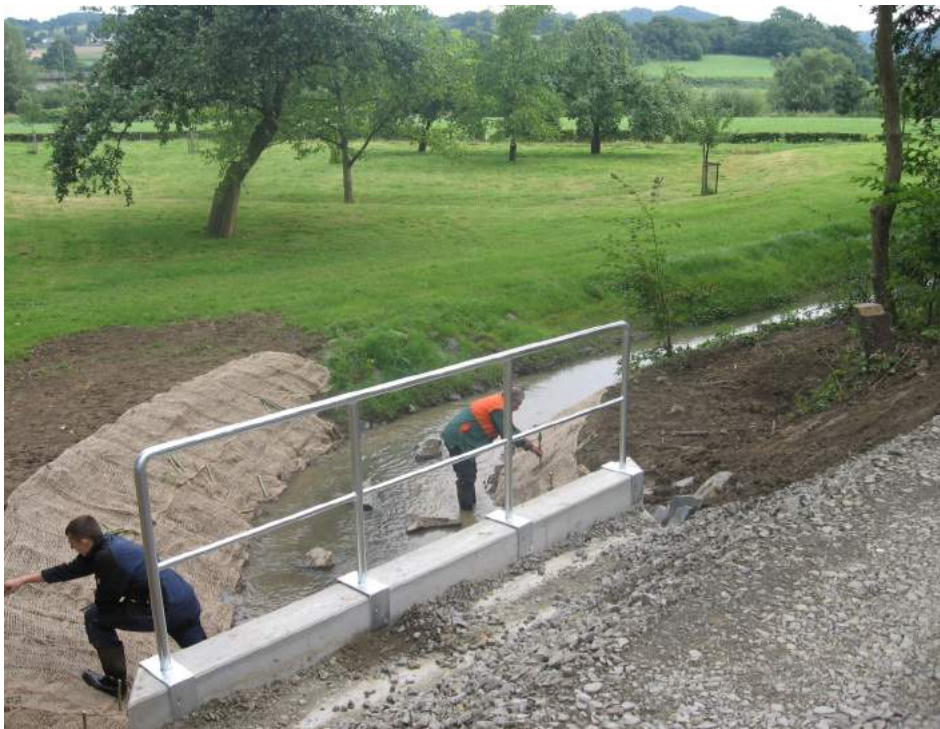
Ahrenbach / Hennef: Böschungsfußsicherung mit Erosionsschutzgewebe.
