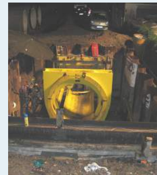
Bau des Durchlasses unter der Bahnstrecke. Beginn der Durchpressung im offenen Vortrieb
