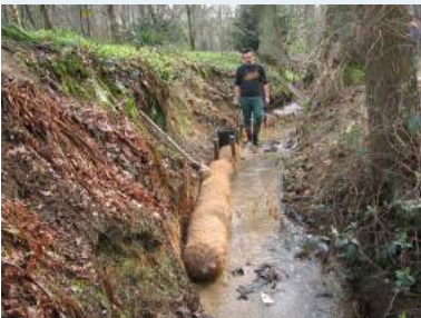
Schleuterbach in Sankt Augustin: auch handwerkliches Geschick ist in der Gewässerunterhaltung notwendig. Gebundene Weidenrollen (Faschinen) sichern Böschungen vor Abrutschungen.
