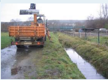
Kningelbach in Sankt Augustin: Feinsedimente werden vom Gewässer mitgeschwemmt und setzen sich an anderen Stellen ab. Dies führt zu einer langsamen Verlandung im Gewässerbett.
